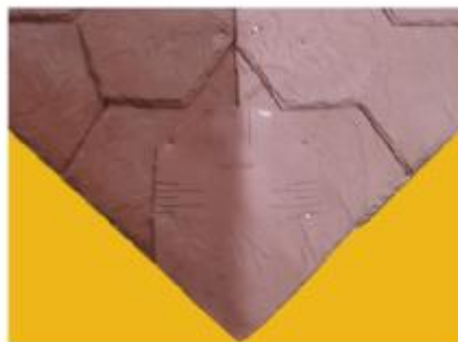
图2：在屋脊底部末端安装第1片屋顶板，此处屋顶板产品根据屋脊底部实际形状尺寸进行裁切安装。
