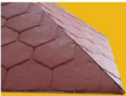
图1：先用合成屋顶板把两边安装好，达到上图效果。
