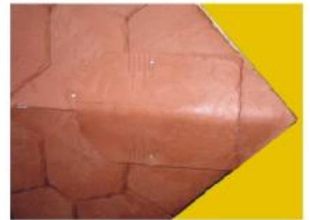
图3：第2片屋顶板覆盖第1片，以此方法由下到上阶梯式安装，直到屋脊顶部。
